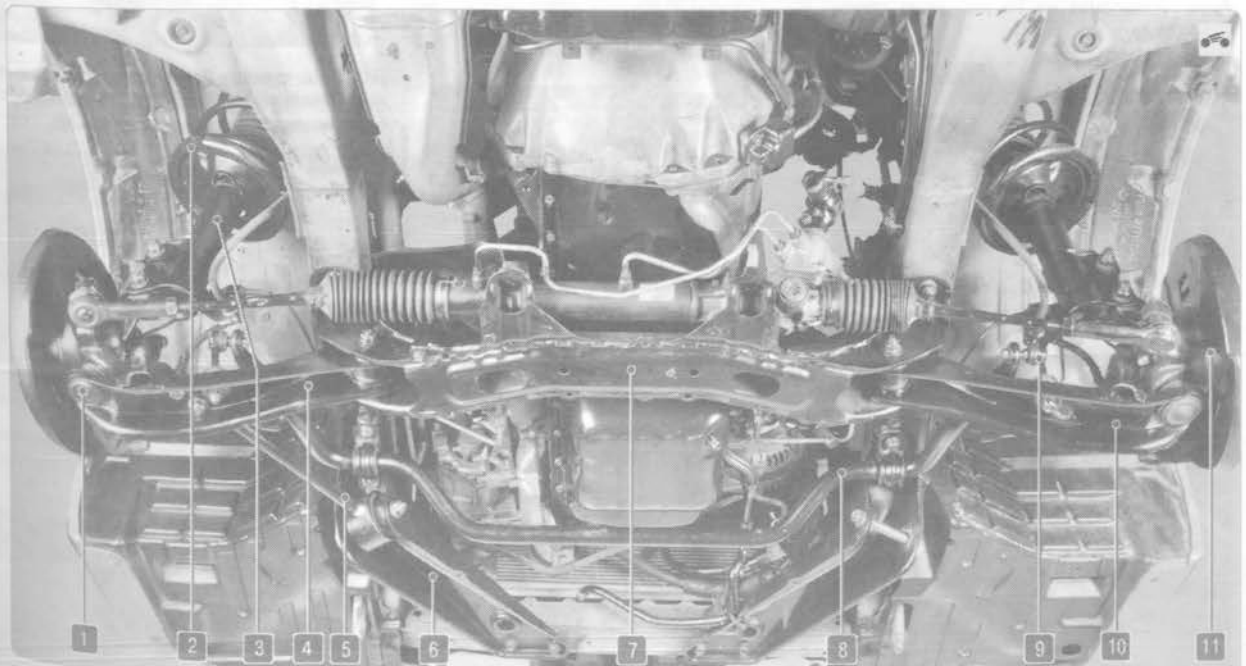
Рис. 7.1. Передняя подвеска: 1 – шаровая опора; 2 – пружина; 3 – телескопическая амортизаторная стойка; 4, 10 – рычаги; 5 – реактивная тяга; 6 – кронштейн реактивной тяги; 7 – поперечина; 8 – штанга стабилизатора поперечной устойчивости; 9 – стойка штанги стабилизатора поперечной устойчивости; 11 – поворотный кулак
